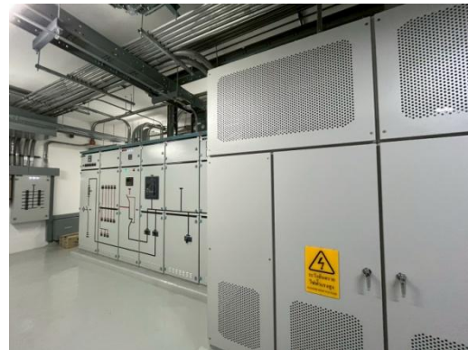
รูปที่ 2-40 ติดป้ายเตือน “ระวังอันตรายไฟฟ้าแรงสูง” บริเวณห้องหม้อแปลงไฟฟ้า
