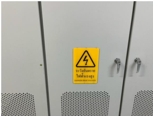
รูปที่ 2-40 ติดป้ายเตือน “ระวังอันตรายไฟฟ้าแรงสูง” บริเวณห้องหม้อแปลงไฟฟ้า
