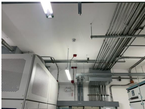
รูปที่ 2-41 จัดให้มีเครื่องตรวจจับสนามแม่เหล็กในห้องหม้อแปลงไฟฟ้า
