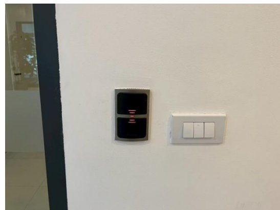
รูปที่ 2-20 ระบบควบคุมการเข้า-ออกอาคาร ด้วยระบบสแกนลายนิ้วมือและระบบคีย์การ์ด
